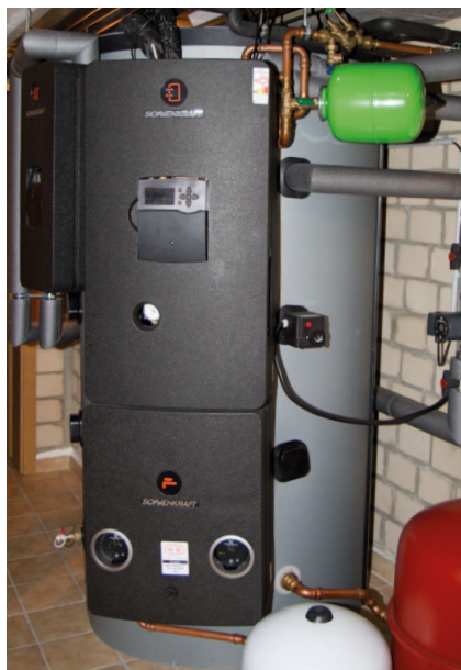
Solarthermie: Ergänzt mit einer Solaranlage – die vom Staat gefördert wird – wird zusätzlich Heizöl gespart.
