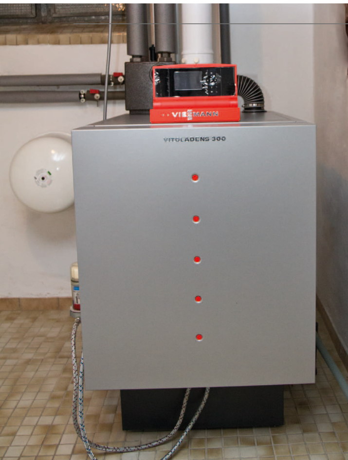
Eine neue Öl-brennwertheizung sorgt für eine 100-prozentige Verwertung des Öls in Wärme.
