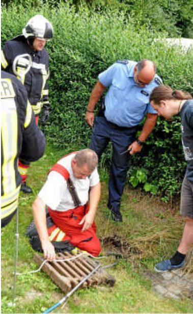
Vorsorglich war die Kanalisation abgedichtet worden. Foto: Peter Hagen
